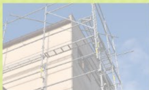
足場仮設工事
